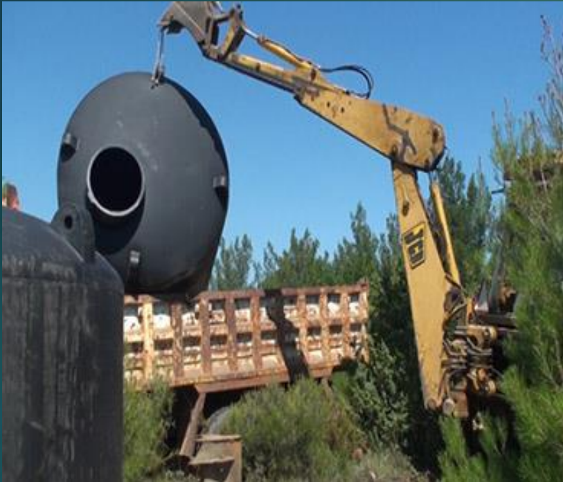
Τοποθέτηση των δύο δεξαμενών
