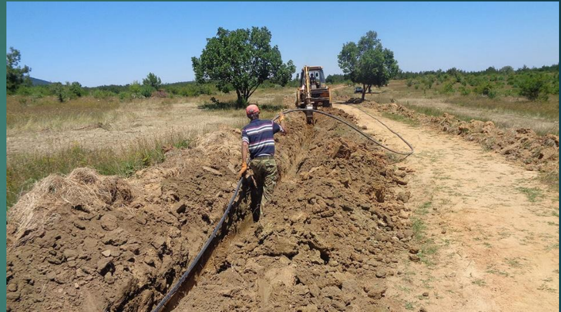
Εγκατάσταση του υπόγειου αγωγού για τη μεταφορά του νερού στις δύο δεξαμενές.
